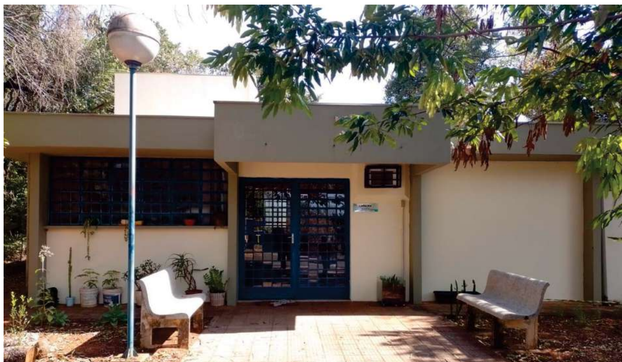
Figura 3. Sede do LAPALMA desde 2014, prédio único na UNESP Bauru, localizado na Alameda dos Jatobás – S/N, em frente ao Centro de Psicologia Aplicada (CPA).
